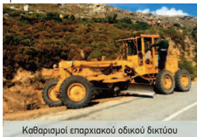
Καθαρισμοί επαρχιακού οδικού δικτύου
