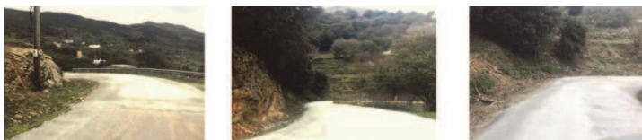
Αποκατάσταση οδοστρώματος Επαρχιακού οδικού δικτύου στην περιοχή Αμμόλοφος
