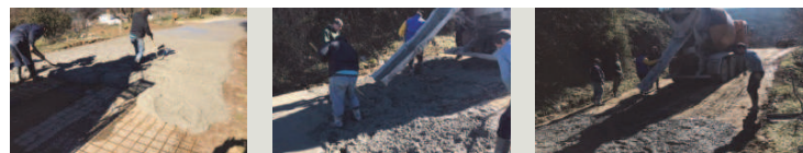
Αποκατάσταση Οδοστρώματος Επαρχιακού οδικού δικτύου στον Αμμόλοφο
