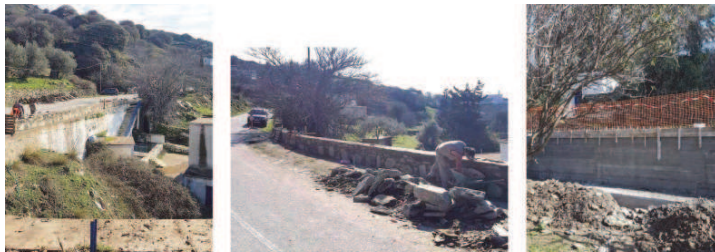
Εργασίες στο Επαρχιακό οδικό δίκτυο στην περιοχή δημοτικού σχολείου Φειλλού
